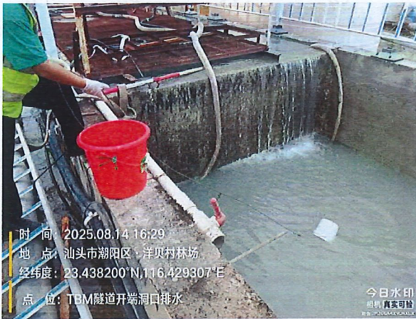
施工 5 标 TBM 隧道开端隧洞洞口排水
