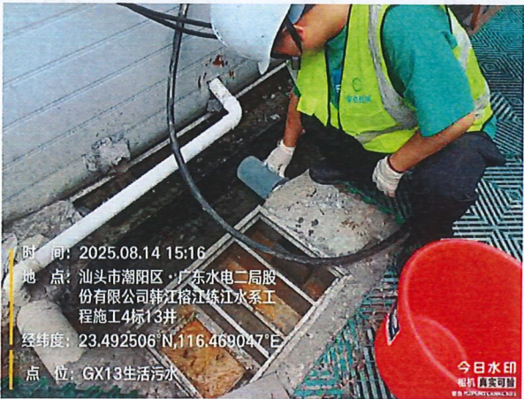
施工 4 标 GX13 厨房生活污水
