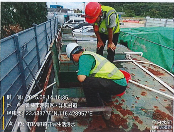
施工 5 标 TBM 隧道开端生活污水
