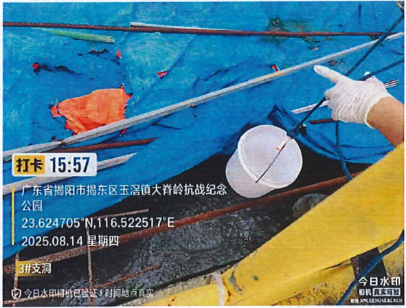
施工 1 标 3#支洞隧洞洞口排水
