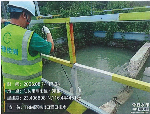
施工 5 标 TBM 隧道出口隧洞洞口排水
