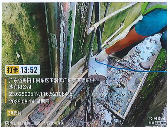
施工 1 标 3#支洞厨房生活污水
