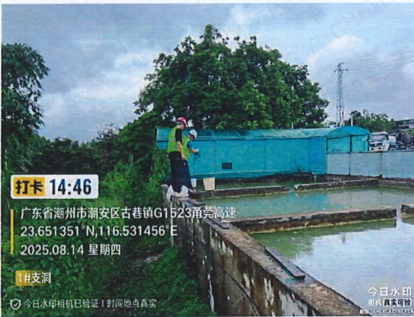
施工 1 标 1#支洞隧洞洞口排水
